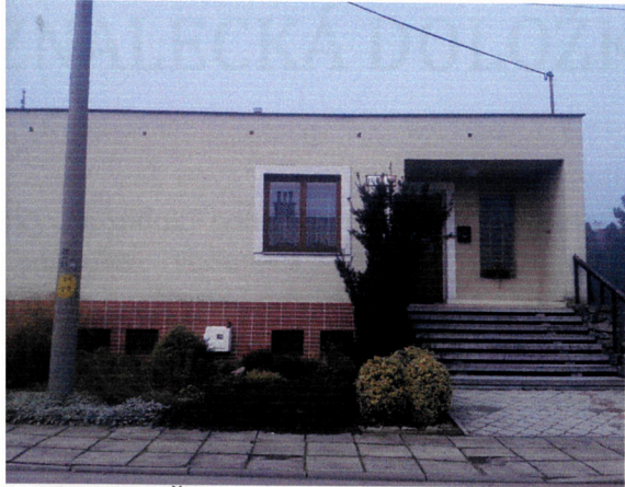
Čelný pohľad z ulice
