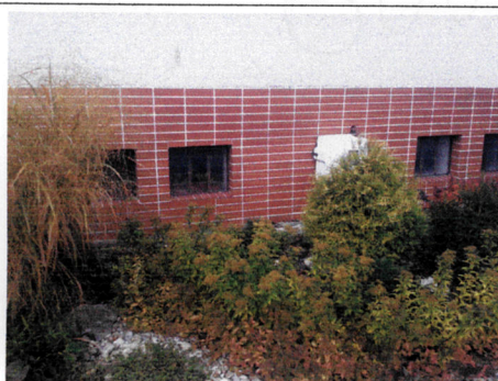
Samotný dom je podpivničený
