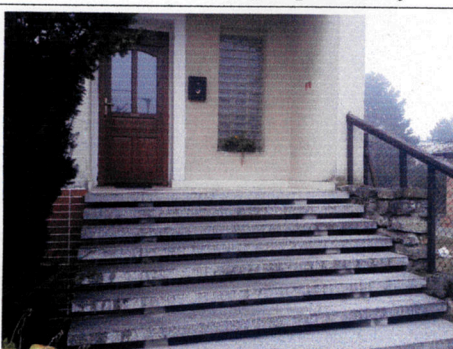
Vstupné predložené schody
